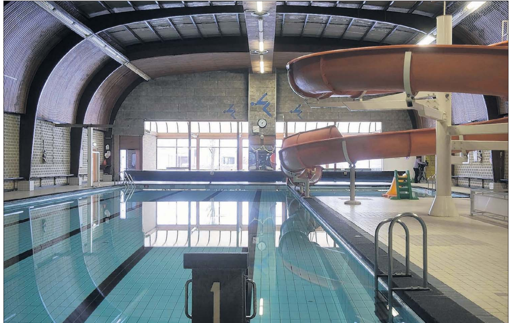
Het zwembad in Melick wordt dit weekeinde leeggepompt. De komende weken wordt beslist over herstelwerkzaamheden of nieuwbouw. foto John Peters
